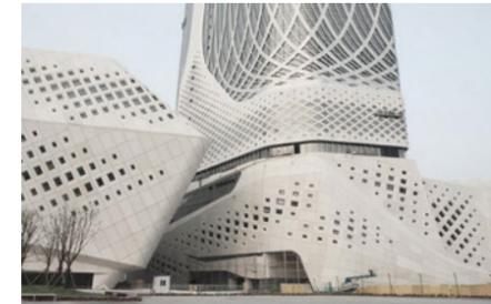
动几何图形。该项目总共使用了11万平方米的GRC墙板，墙板由南京倍立达公司制造，使用了萨门特集团安庆工厂生产的52.2级高强度阿尔博®白水泥，墙板的尺寸和形状各不相同。每块墙板都具有独一无二的单抛物线或双抛物线设计，以实现复杂的曲面结构。
