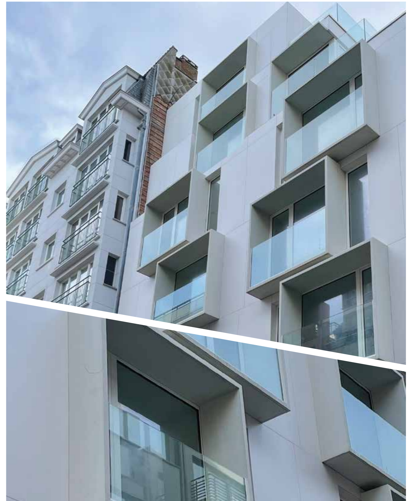
UHPC结构阳台 路易莎街住宅楼 比利时奥斯坦德, 2021
