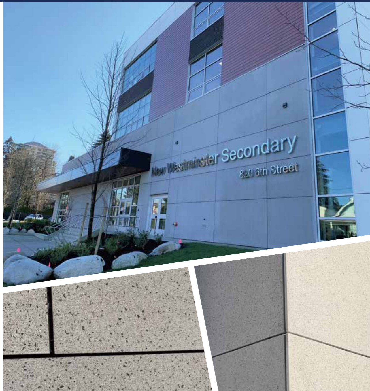
UHPC 超薄幕墙 新威斯敏斯特中学(NWSS)翻修项目 加拿大, 2020
